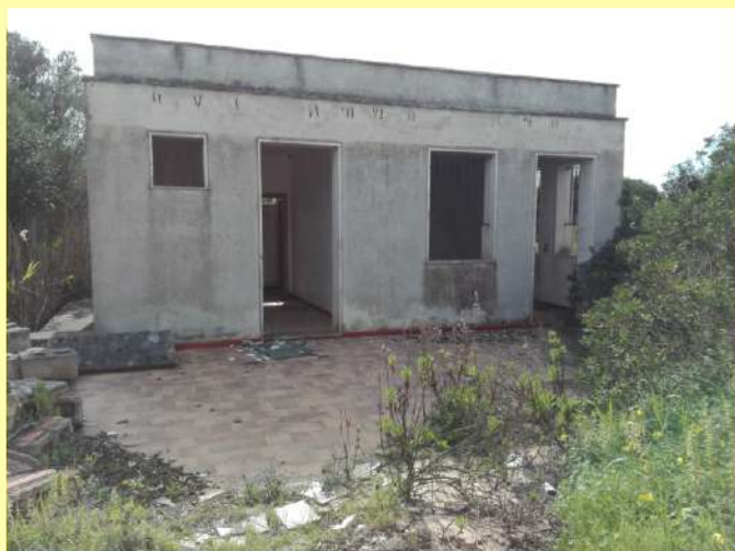
Fig. 27. Fabbricato lungo la strada che conduce all'Osservatorio ecologico, oggetto dell'intervento I.9 Abbattimento fabbricati in disuso.
